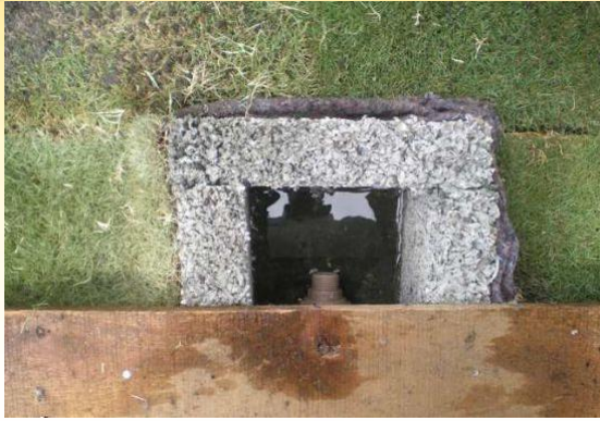
Figura 7 – Detalhe do dreno lateral 4 cm acima da laje impermeabilizada.
