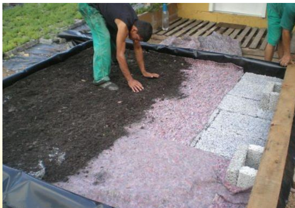
Figura 5 – Colocação do substrato leve fibroso. Fonte: https://goo.gl/vbCq2m
