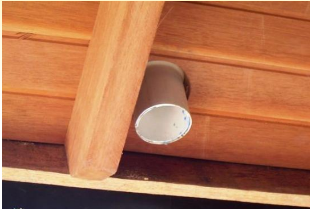
Figura 3 – Detalhe do dreno visto por baixo do forro com saída pela membrana. Fonte: https://goo.gl/LFeu1z
