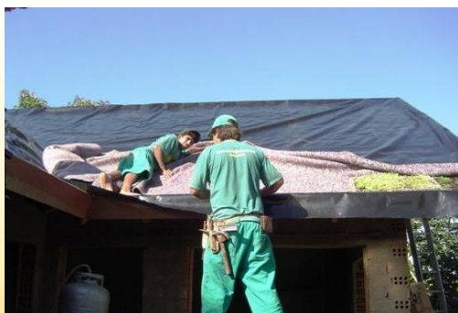
Figura 1 – Membrana anti-raízes, em preto, já instalada. Fonte: https://goo.gl/epwvRn
