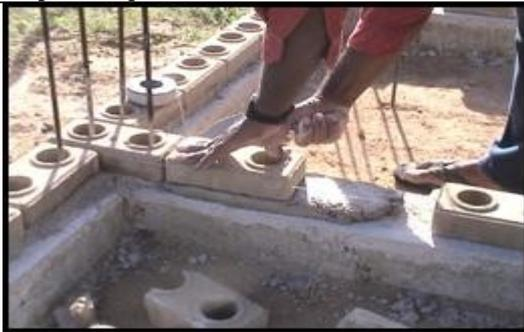
**Foto 15:** Execução da 1ª fileira (guia) da alvenaria de solo-cimento
