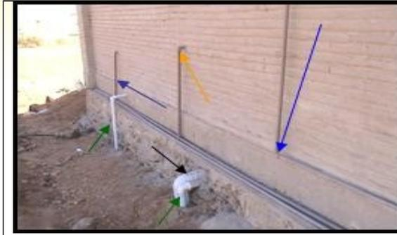
**Foto 29:** água da cisterna direcionada para cozinha; água da caixa d'água para a lavanderia; água de reuso da lavanderia; afluente de pia de cozinha/banheiro e chuveiro para tratamento em filtro de areia; afluente de descarga para tratamento anaeróbio.
