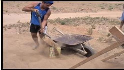
**Foto 04:** Dosagem racional do solo para a mistura solo-cimento.
