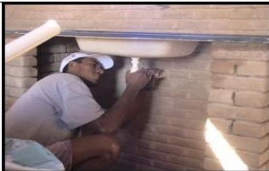
**Foto 17:** Instalações sanitárias embutidas
