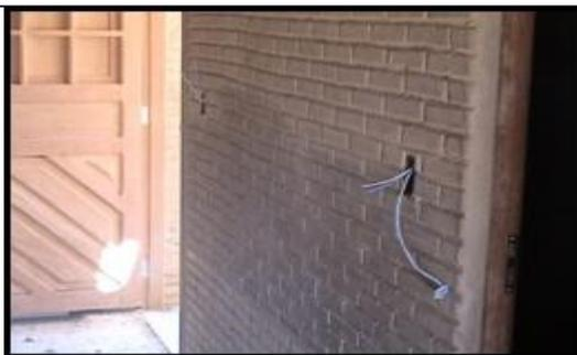
**Foto 19:** instalações elétricas embutidas dispensando a quebra das paredes.
