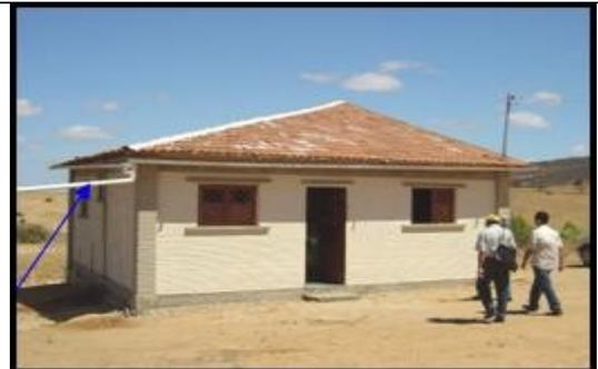
**Foto 34:** Residência finalizada com sistema de aproveitamento e direcionamento das águas das chuvas para a cisterna de placas.
