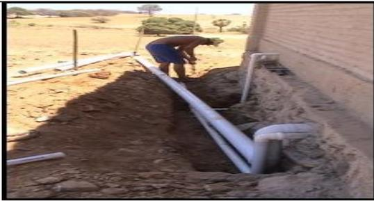
**Foto 31:** Execução da tubulação dos afluentes.
