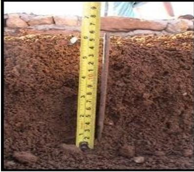
**Foto 13:** Camadas de 15cm de solo não compactado para o caixão da residência
