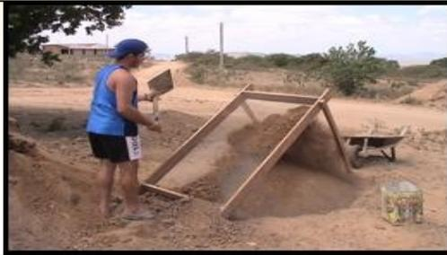
**Foto 03:** Processo de peneiramento do solo escolhido para a confecção dos tijolo.
