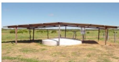
**Figura 01:** Cisterna rural de placas pré-moldadas.
