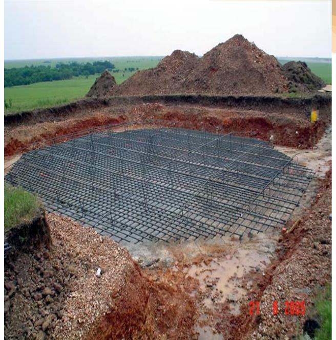
Figura 3 – Início da fundação para sustentação da turbina eólica
