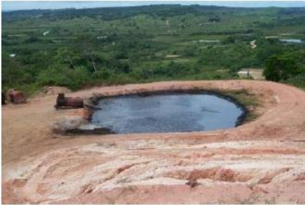
Figura 1: Dique alto do morro de Jericó/SE em 2002 (ALVES, 2003).
