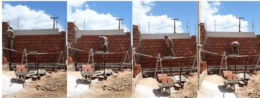
Figura 5: Sequência de posturas no assentamento de tijolos.
