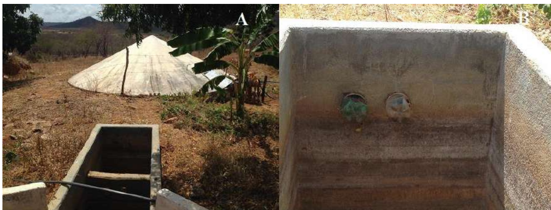
Figura 6: (A) Cisterna de enxurrada do lote 03 e (B) tampão feito pelo agricultor para evitar a entrada da água proveniente da chuva. Fonte: MOURA, M. B. M, 2017
