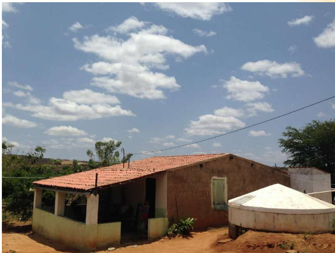
Figura 4: Cisterna de Placas da PIMC, em lote do assentamento Laginha, Serra Talhada -PE. Fonte: MOURA, M. B. M. 2017
