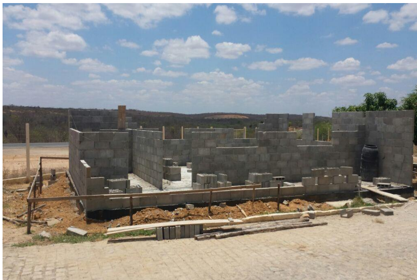
Figura 05 – Construção do Espaço PROEJA, através de aulas práticas
