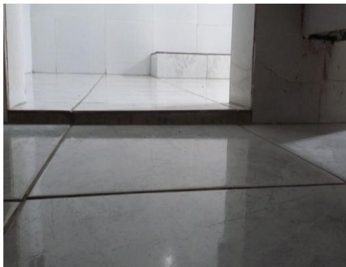
degraus na entrada, tornando-a inadequada do ponto de vista a acessibilidade.
